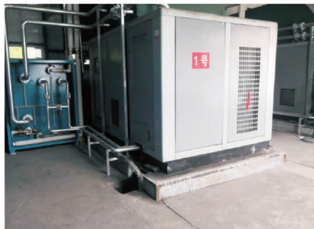
▲ 山西翼城阳煤集团华鸿煤矿
