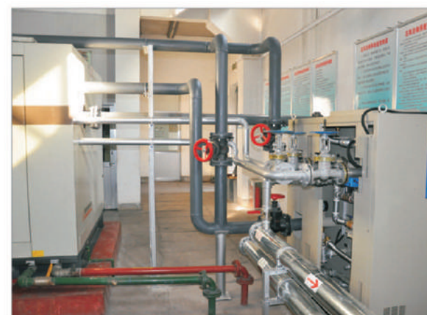
▲ 无油机油气双回收改造
