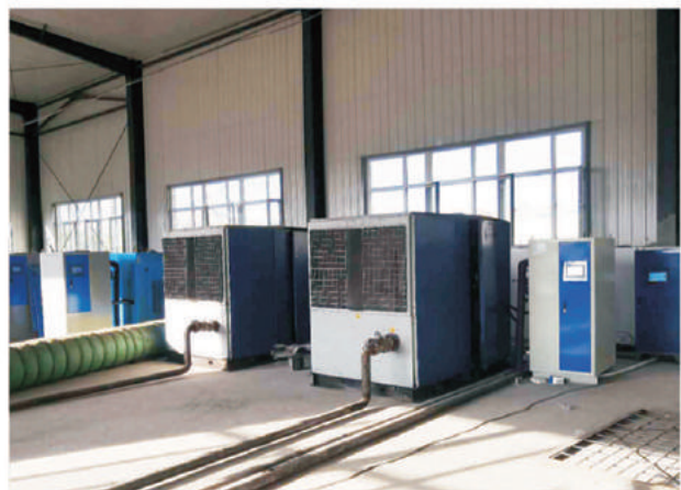
▲ 新疆昌吉宝平煤业有限公司 4台132空压机余热回收, 满足500人洗澡
